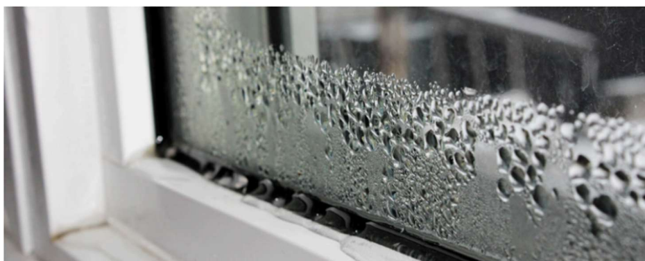
Image 1. Photo montrant le phénomène de condensation à l'intérieur des unités scellées
