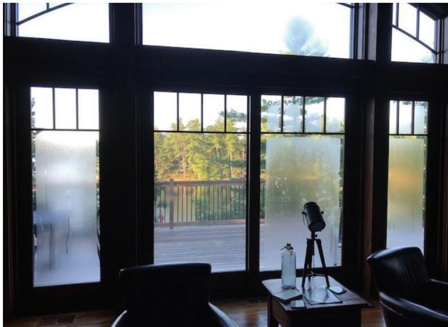
Image 2. Photo montrant le phénomène de condensation à l'extérieur des unités scellées.
